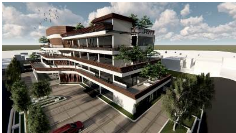
Gambar 3. Perspektif Bentuk Terasiring pada Bangunan Sumber : Analisa Penulis, 2020
